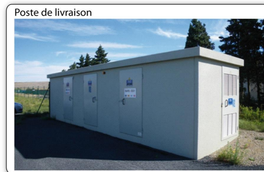
Photographie 3 : Poste de livraison
