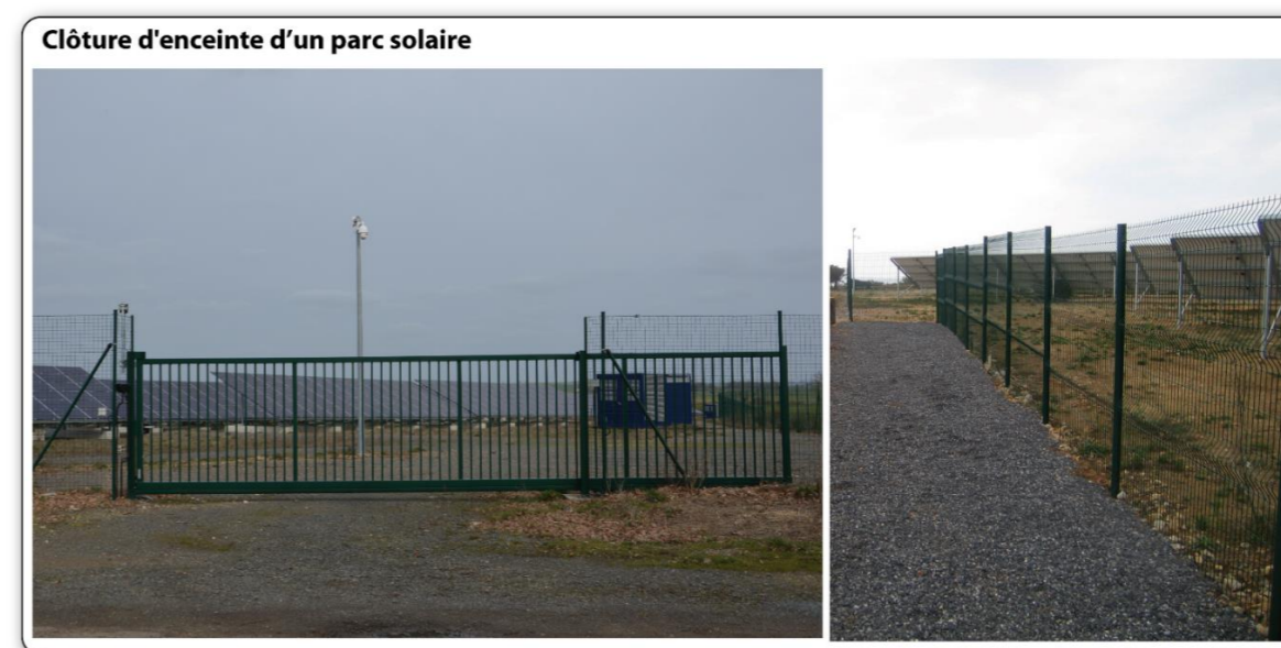
Figure 18 : Clôture de sécurité
